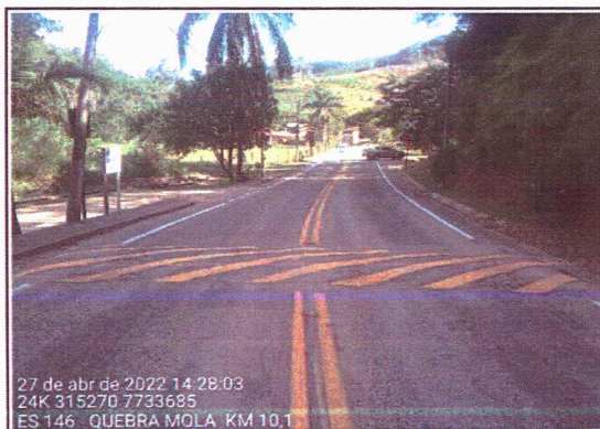
Execução de Sinalização Horizontal
