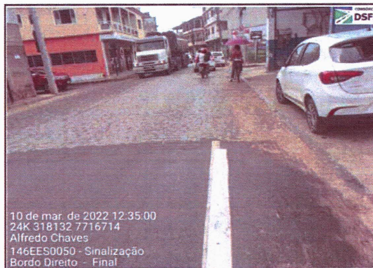
Execução de Sinalização Horizontal
