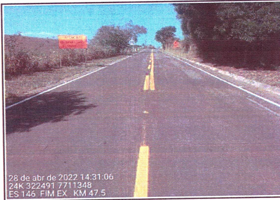
Execução de Sinalização Horizontal
