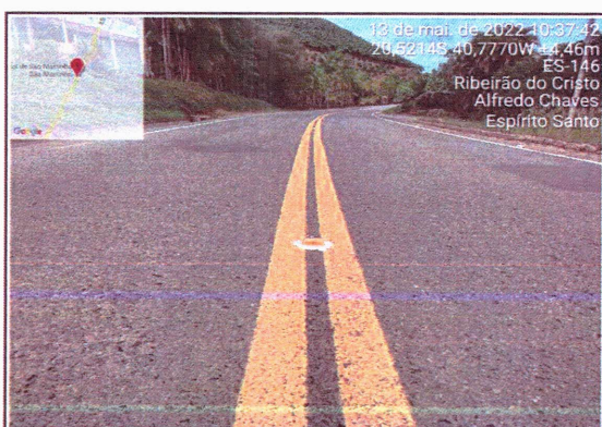
Implantação de Tacha Birrefletorizada
