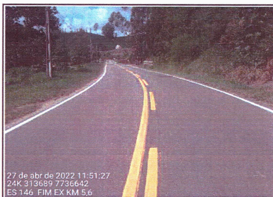
Execução de Sinalização Horizontal
