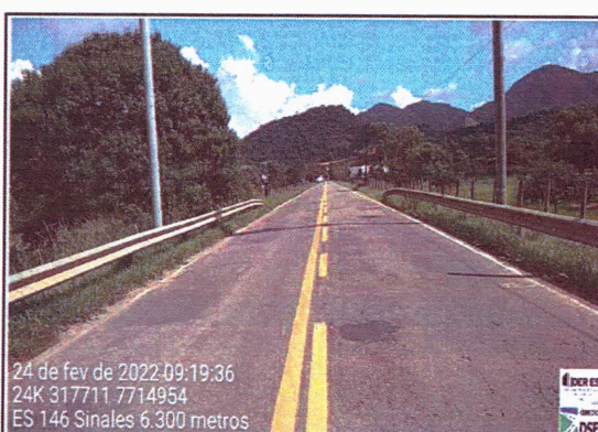
Execução de Sinalização Horizontal
