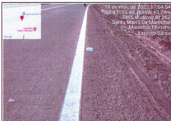
Implantação de Tacha Birrefletorizada
