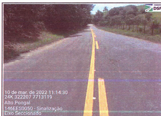
Execução de Sinalização Horizontal
