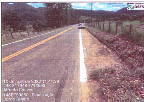
Execução de Sinalização Horizontal
