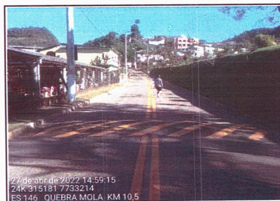
Execução de Sinalização Horizontal
