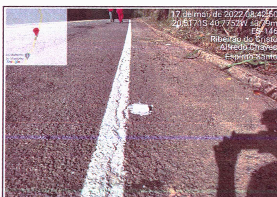
Implantação de Tacha Birrefletorizada
