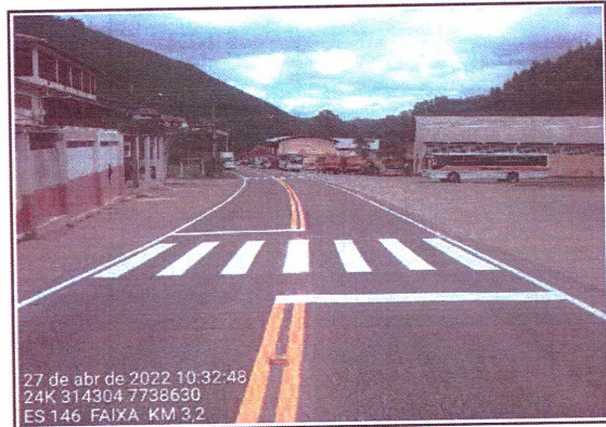
Execução de Sinalização Horizontal
