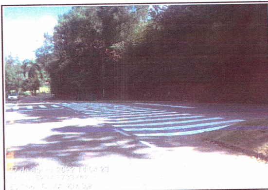
Execução de Sinalização Horizontal
