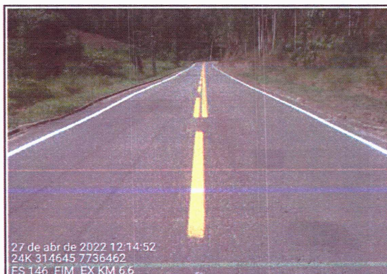
Execução de Sinalização Horizontal
