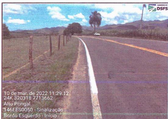
Execução de Sinalização Horizontal
